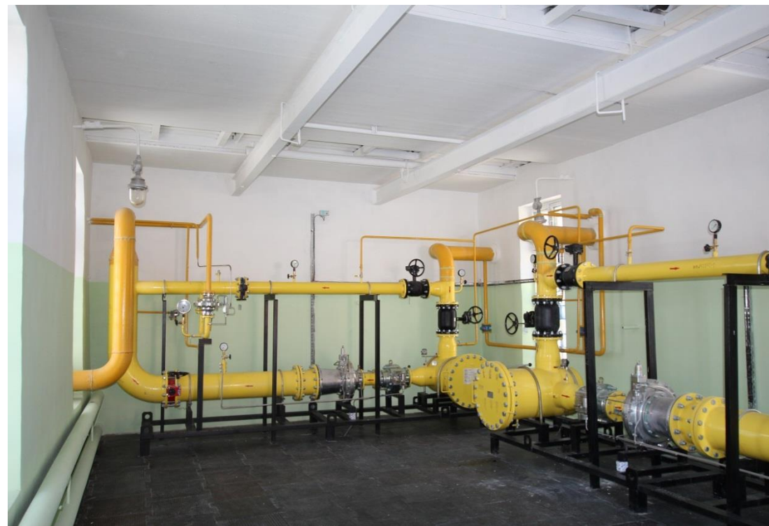
ГРП №1 ГОЛОВНОЕ после реконструкции
